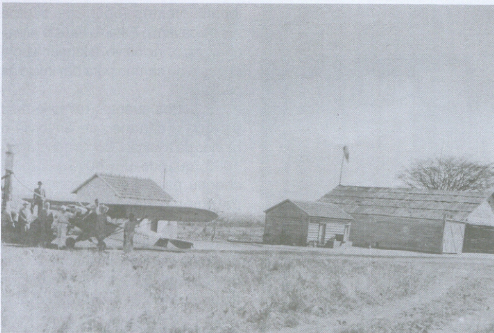
Vista geral do Campo de Aviação onde se vê o hangar. Década de 1940. (Acervo Dalva Santos Zema).
